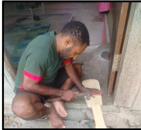
Gambar 29. Peneliti Memaku Papan Untuk Menutupi Lubang Suara Ukulele Sumber: Koleksi Peneliti
